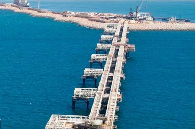
GORGON LNG PROJECT MOF, Barrow Island, WA (KBR)
